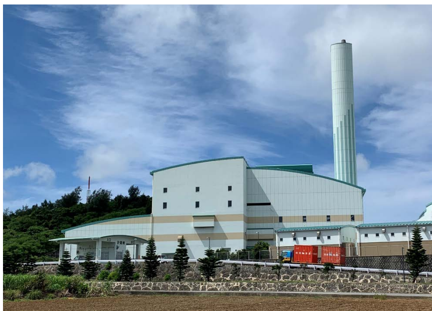
図2-3 宮古島市クリーンセンター（ごみ焼却棟）の外観
