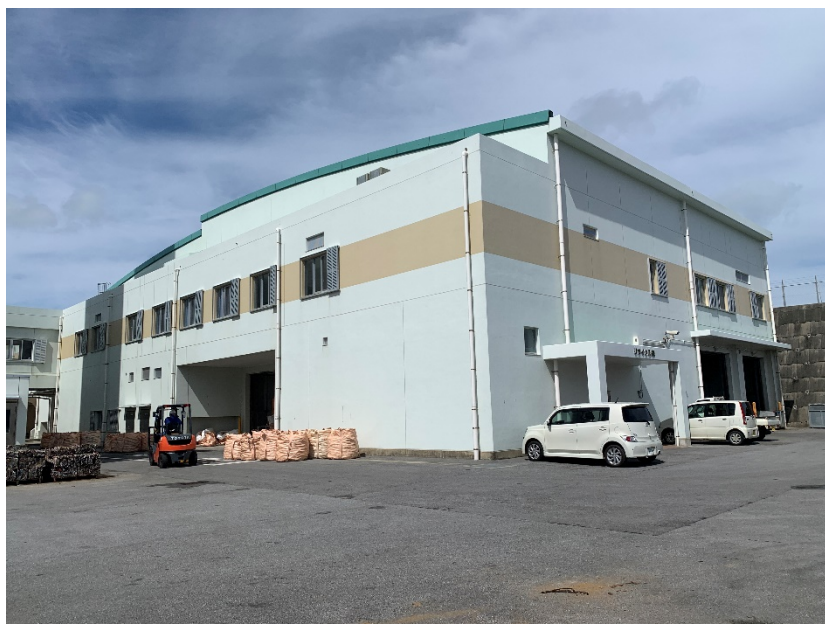
図 2-4 宮古島市クリーンセンター（リサイクル棟）の外観
