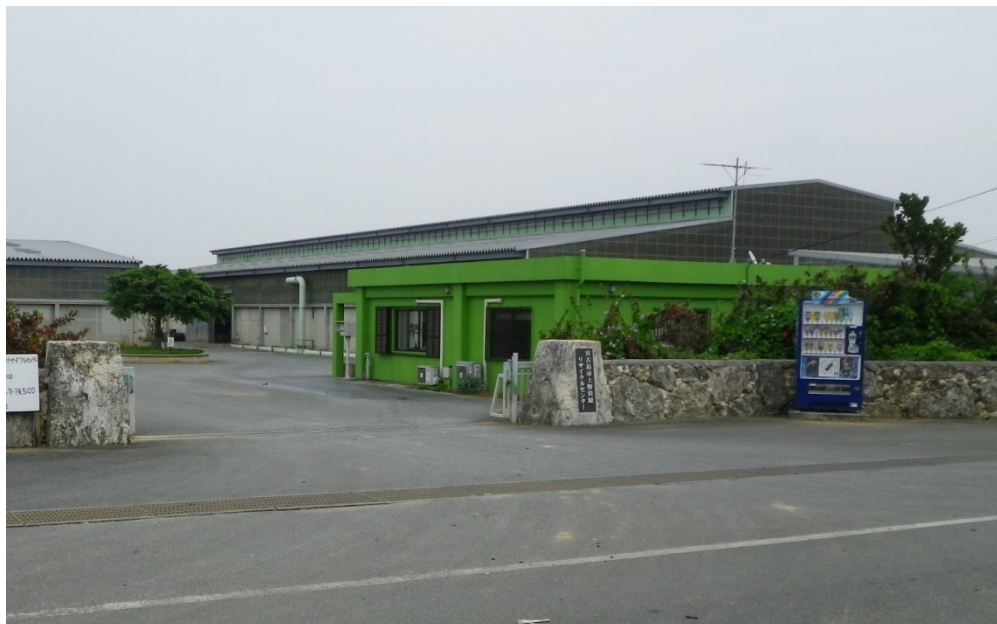
図 2-7 宮古島市資源リサイクルセンターの外観
