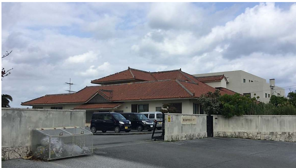
図 3-4 宮古島市公共下水道施設の外観
